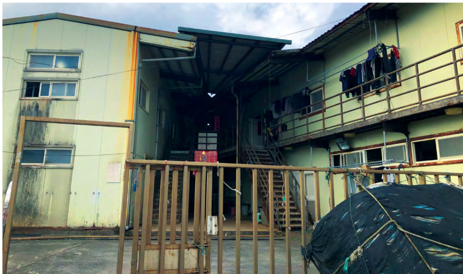
大溪漁港岸置中心
